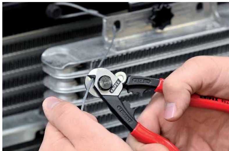
Anpressen der Endhülse an die Bowdenhülle
