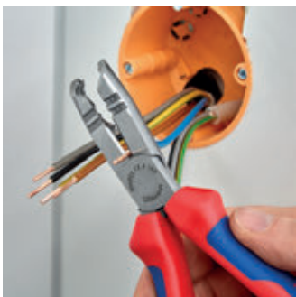
Schneiden beim Einkürzen von Einzelleitern
