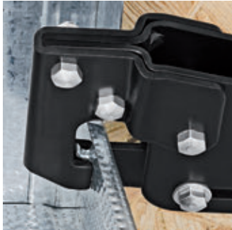
Das Stempelwerkzeug wird durch die Profilbleche gedrückt
