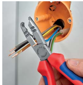
Realizar cortes al acortar conductores individuales
