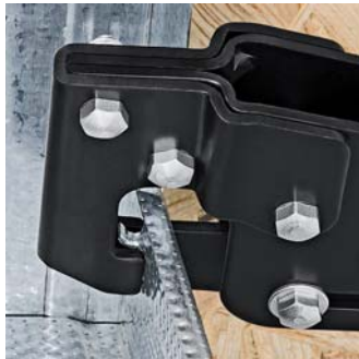
Colocar el alicate para la conexión de dos secciones de laminas de metal
