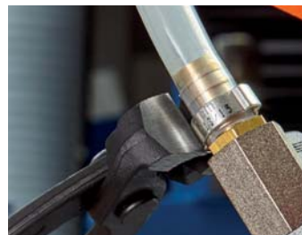
10 98 I220: Afdichten slangaansluiting bij centrale smering
