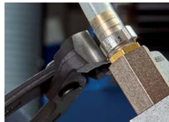
10 98 I220: Vedando a conexão de mangueira na lubrificação central
